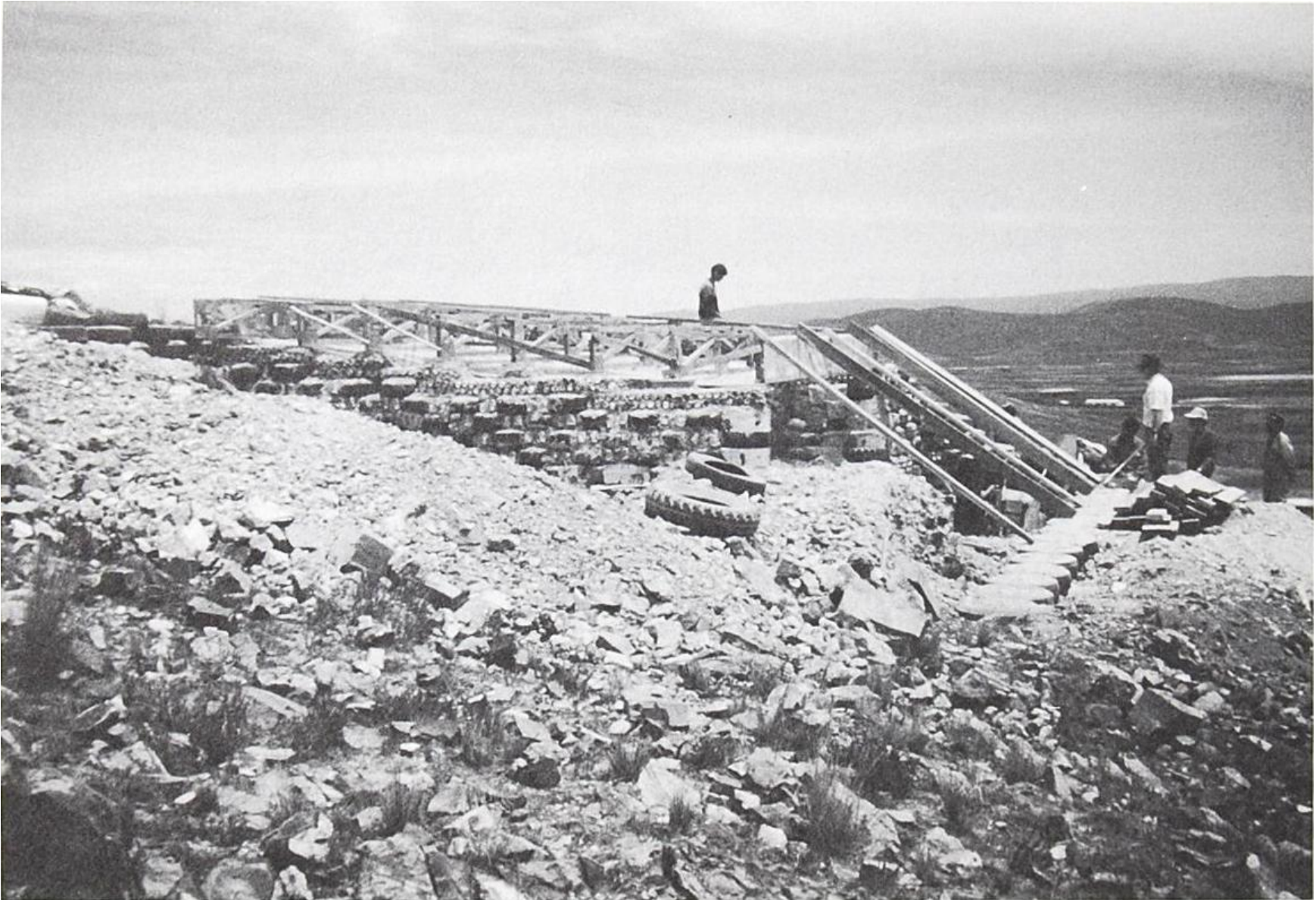
NAVETIERRA A 330 METROS EN BOLIVIA, MOSTRANDO EL ÁNGULO DEL INVERNADERO DIFERENTE, PARA EL SOL MÁS ALTO CERCA DEL ECUADOR.
