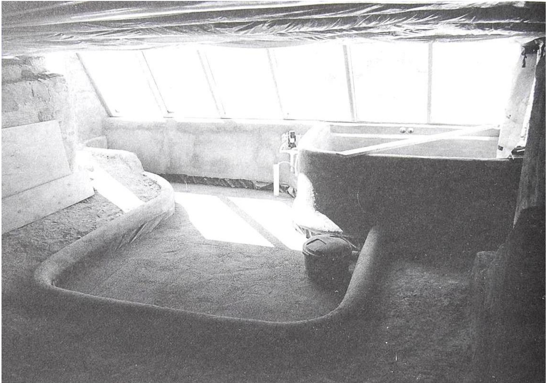
tanque de absorción de aguas grises y cisterna en construcción
