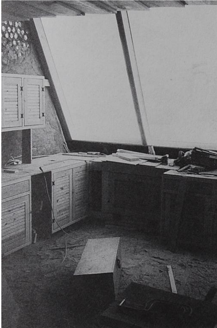
HORNO SOLAR EN CONSTRUCCIÓN
