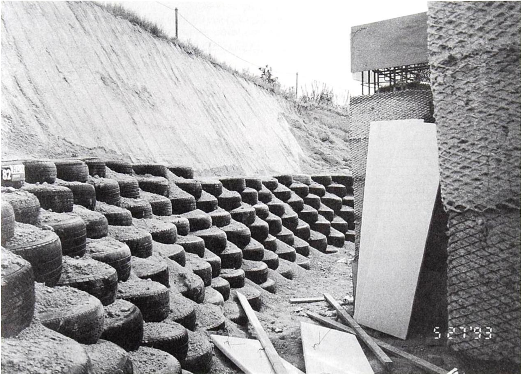
MURO DE RETENCIÓN DETRÁS DE UNA NAVETIERRA EN JAPÓN.
